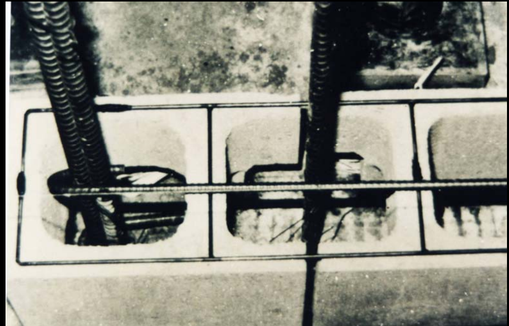
Malla electrosoldada, con escalones @ 20cm
