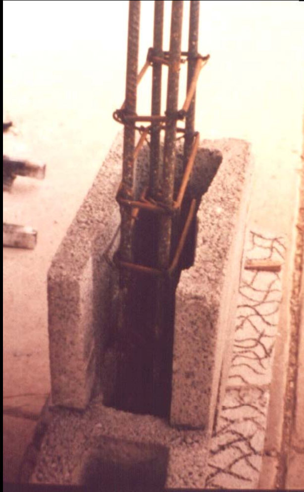
Estribos, para bloques de t = 19\text{cm}
