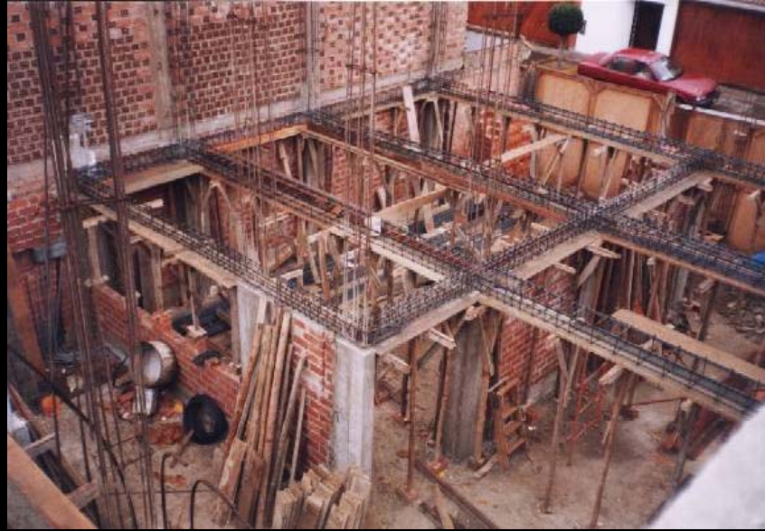
Colocación de los bloques del techo
