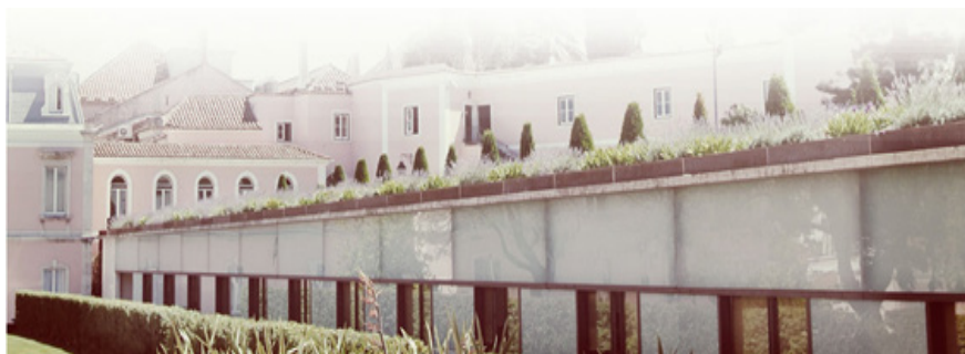
Edifício da Direção de Serviços de Documentação e Arquivo
