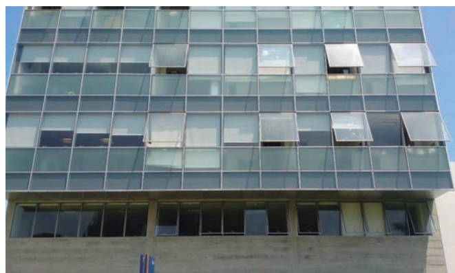
Nuevo edificio de la Facultad de Derecho
