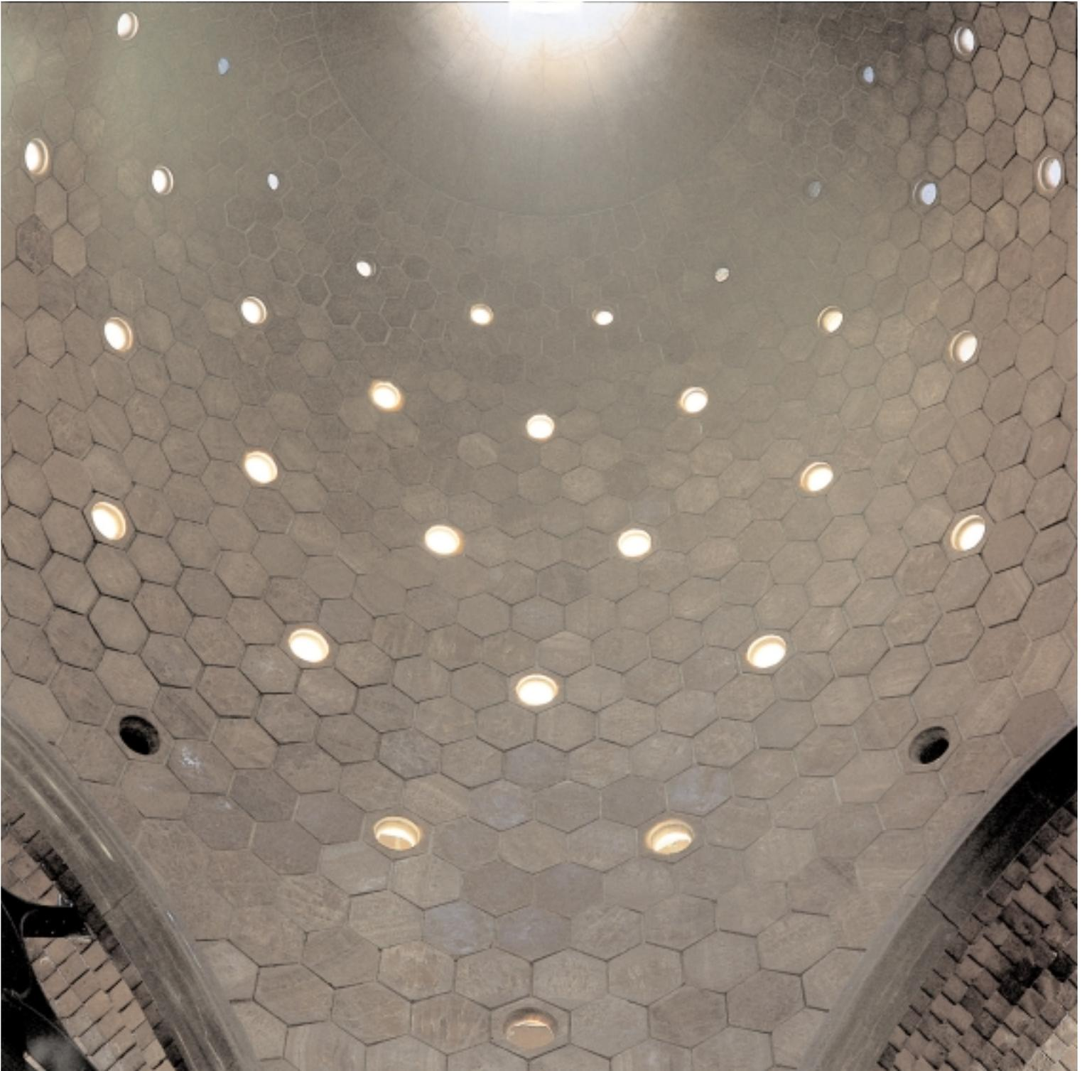
Paraboloide de revolución del Palau Güell, con decoración hexagonal y entradas de luz cenital inspiradas en la Alhambra de Granada
