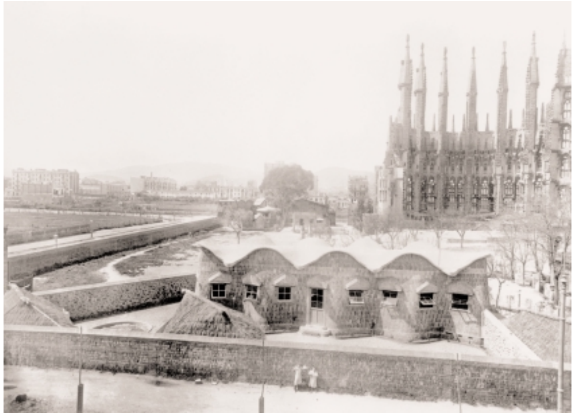
Conoides de la cubierta y los muros de las Escuelas Provisionales de la Sagrada Família
