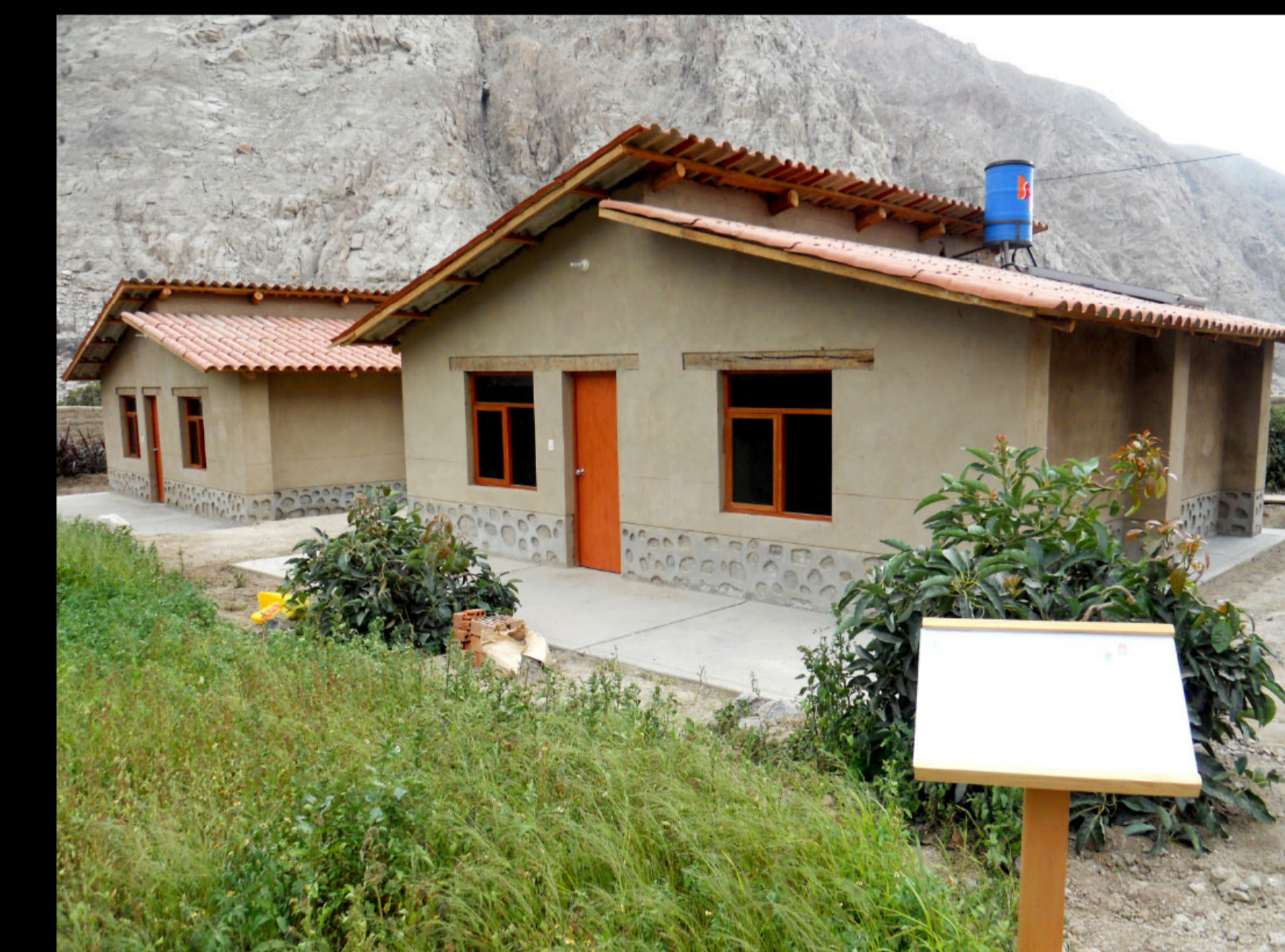
Bungalow con tecnologías amigables con el medio ambiente: Terma solar y aerogenerador.
