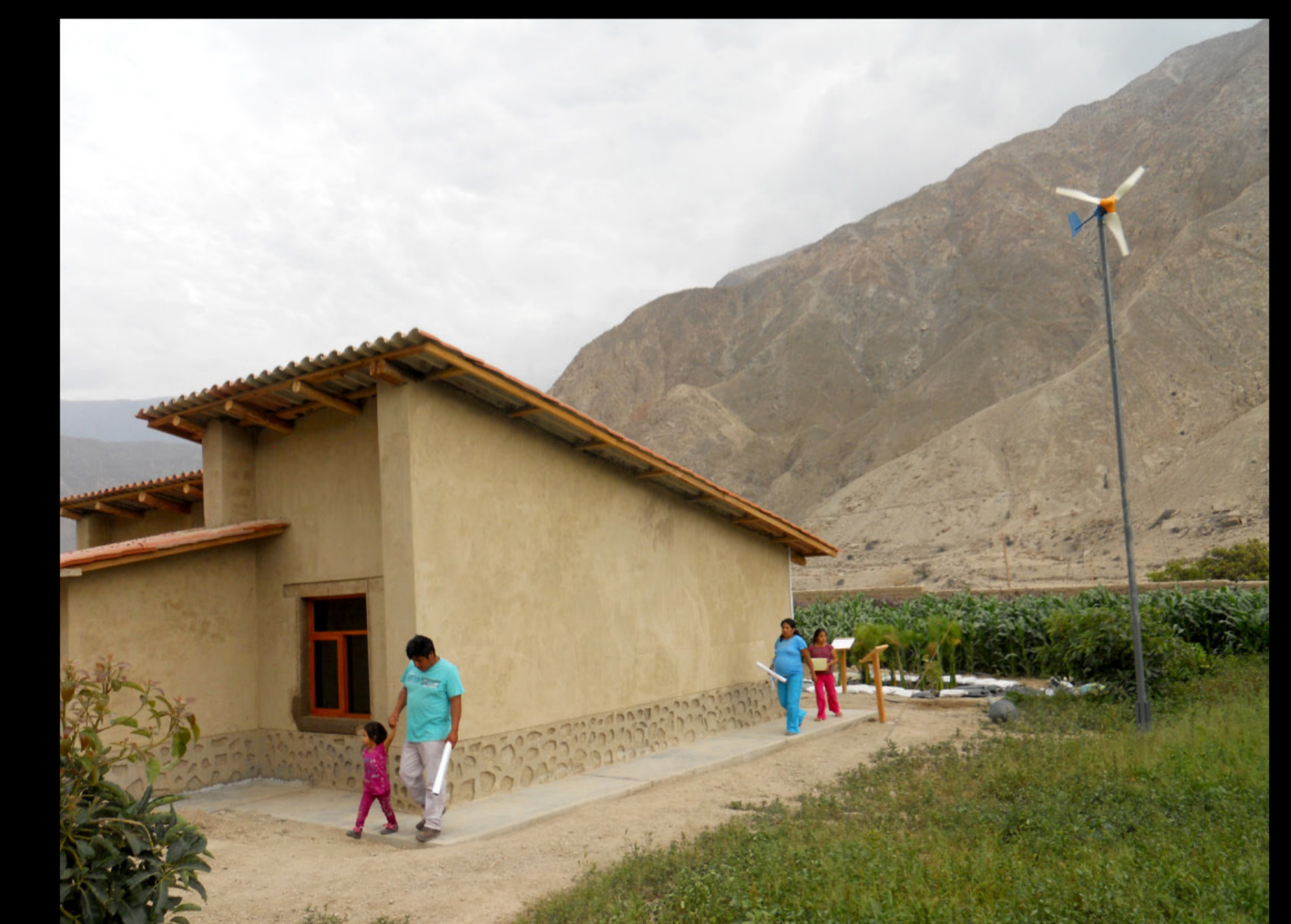
Aerogenerador para electrificación de los bungalows.
