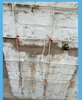
Detalle del reforzamiento con driza de 1/4" horizontal y vertical con templadores.
