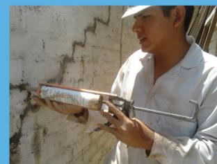
Proceso de inyección de fisuras con barro líquido.
