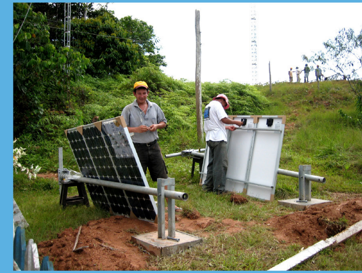
Instalación de paneles solares en el CS Santa Clotilde – Napo – Loreto.
