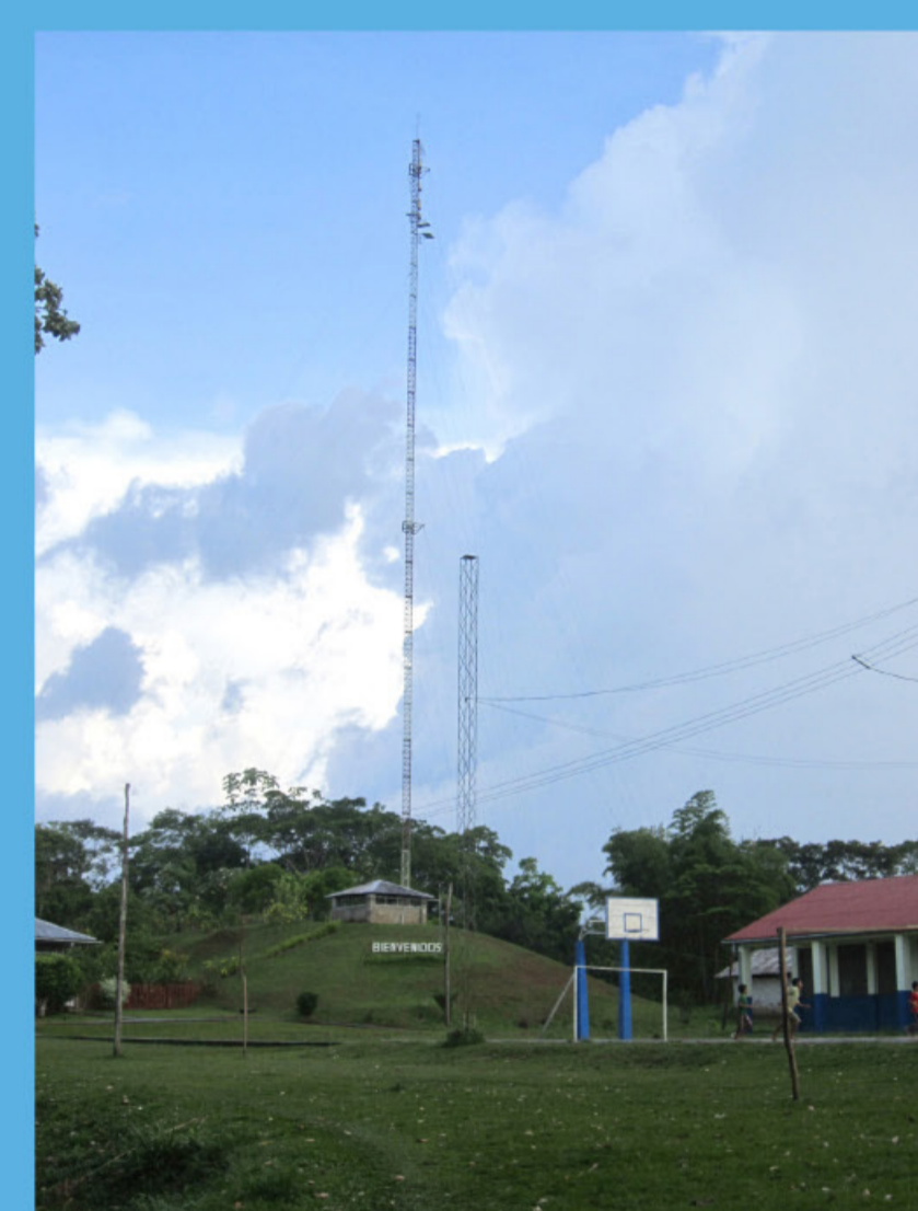
Vista de la torre de 72m del CS Santa Clotilde – Napo – Loreto.
