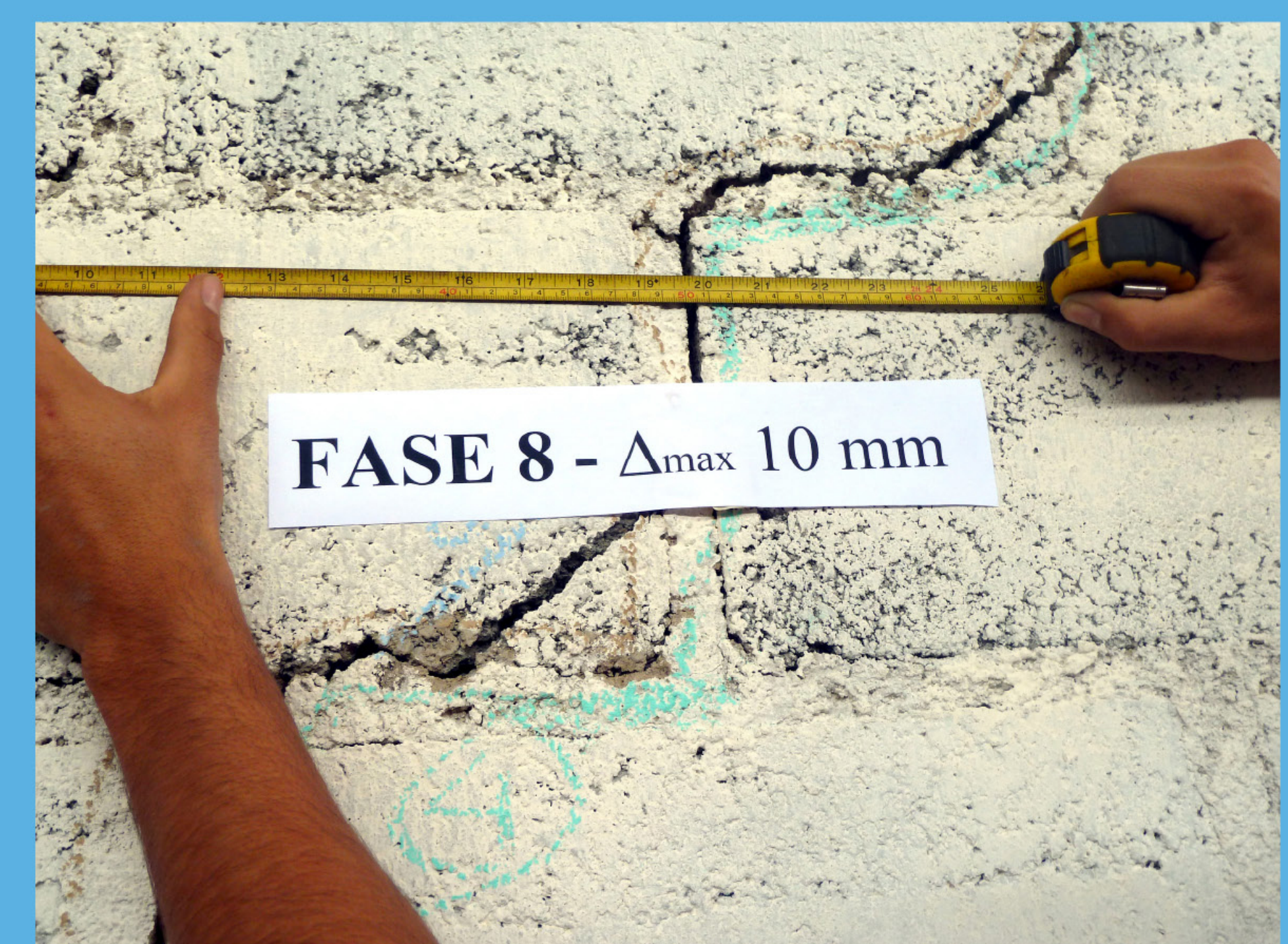
Mediciones durante el ensayo de carga lateral en muro.
