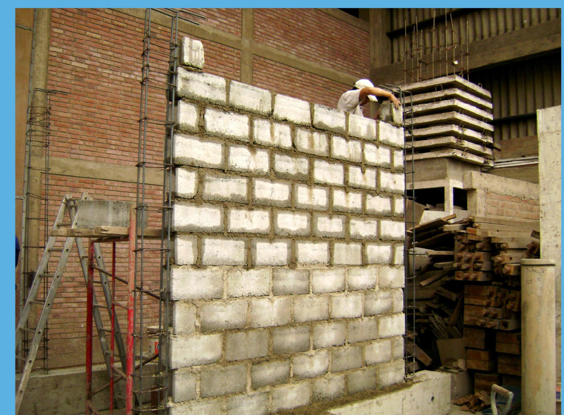
Construcción de muro confinado.
