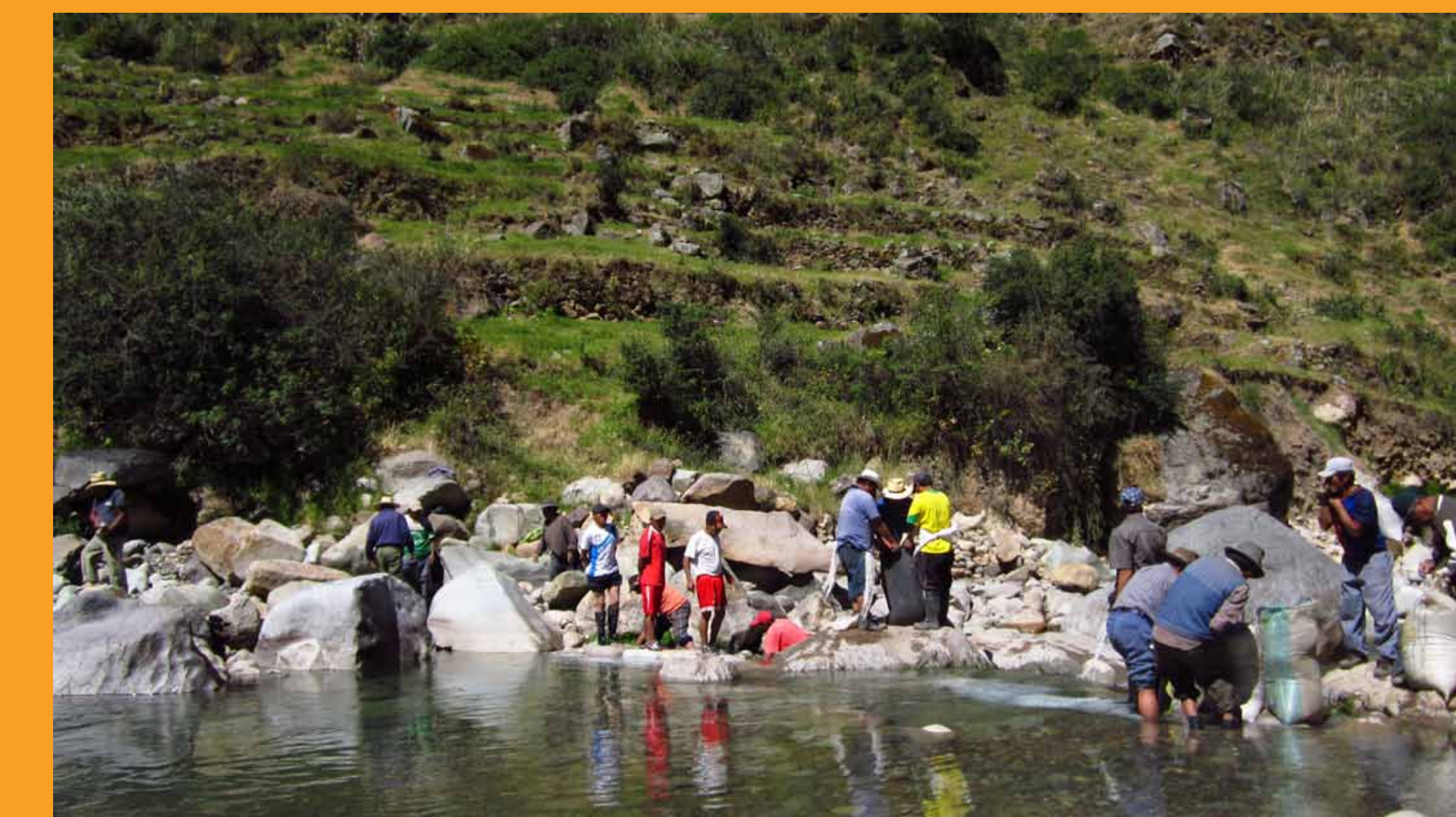
Comuneros de Santa Rosa de Tambo construyen defensas ribereñas. Utilizan costales, cemento y hierbas para construir diques rústicos y darle curso al río Tambo.
