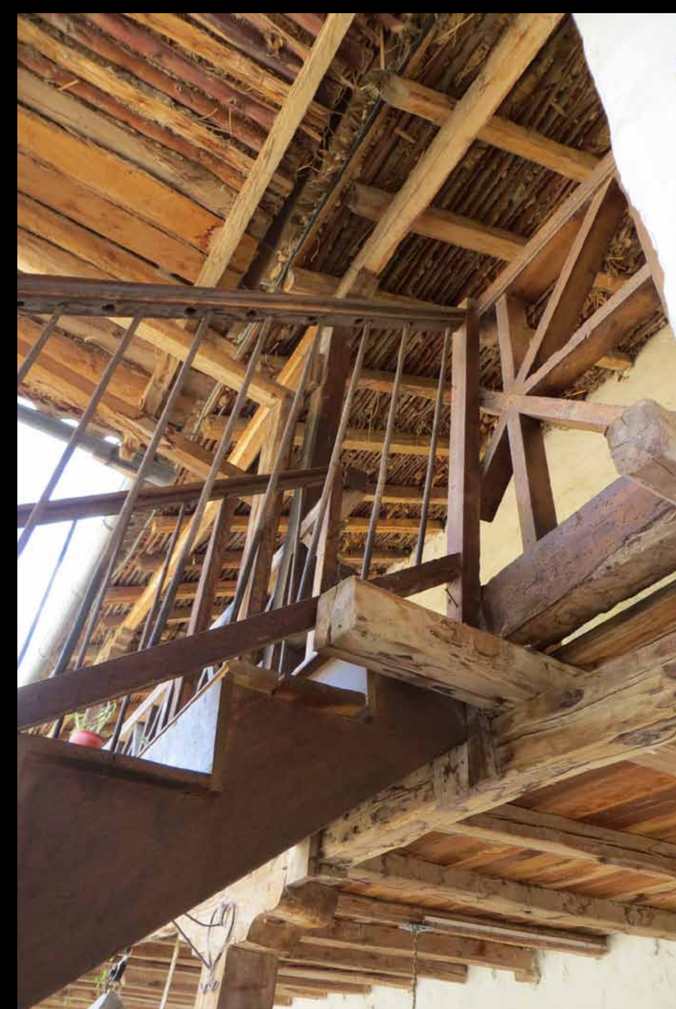
Estructura en madera.
