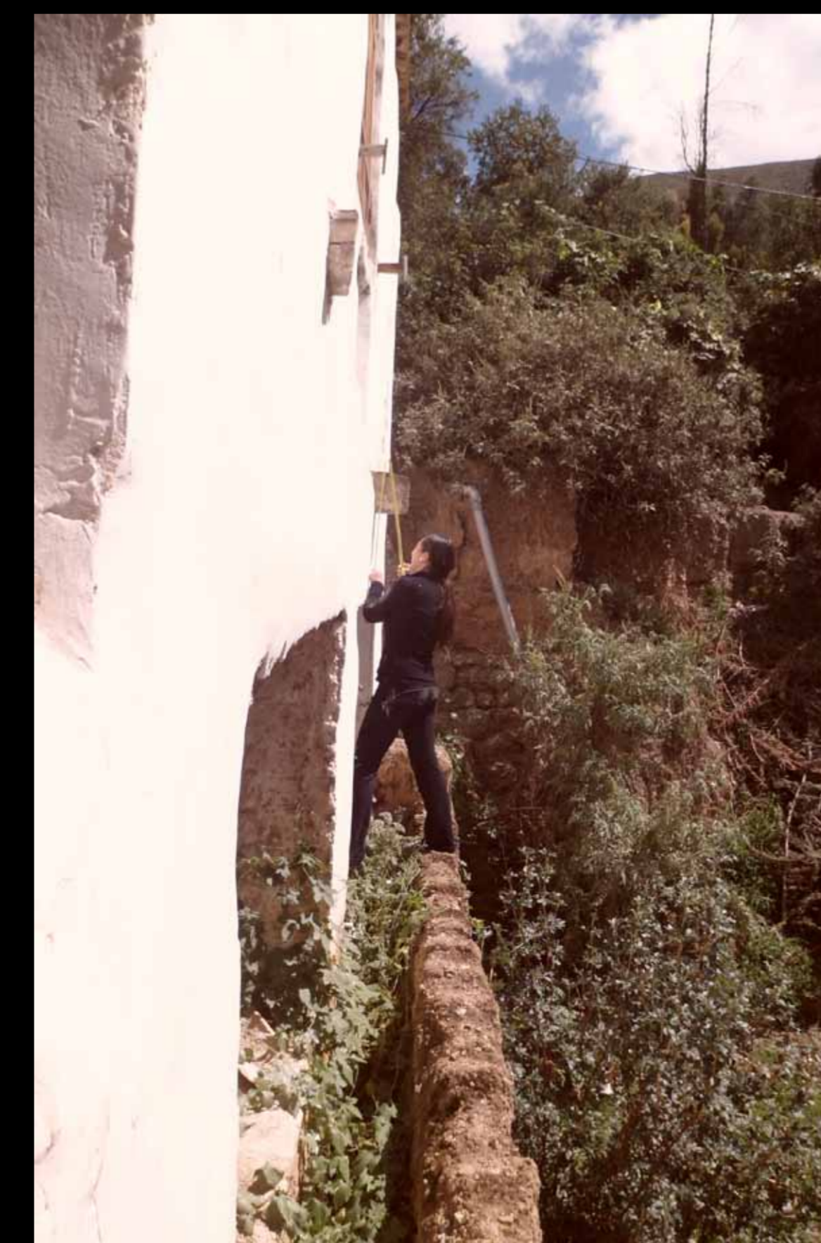
Haciendo inspección y levantamiento.
