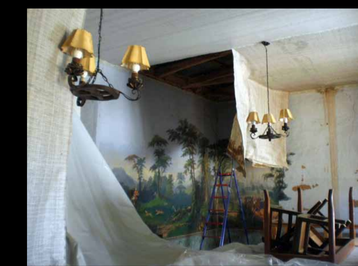
Desmontando el cielo raso del comedor.
