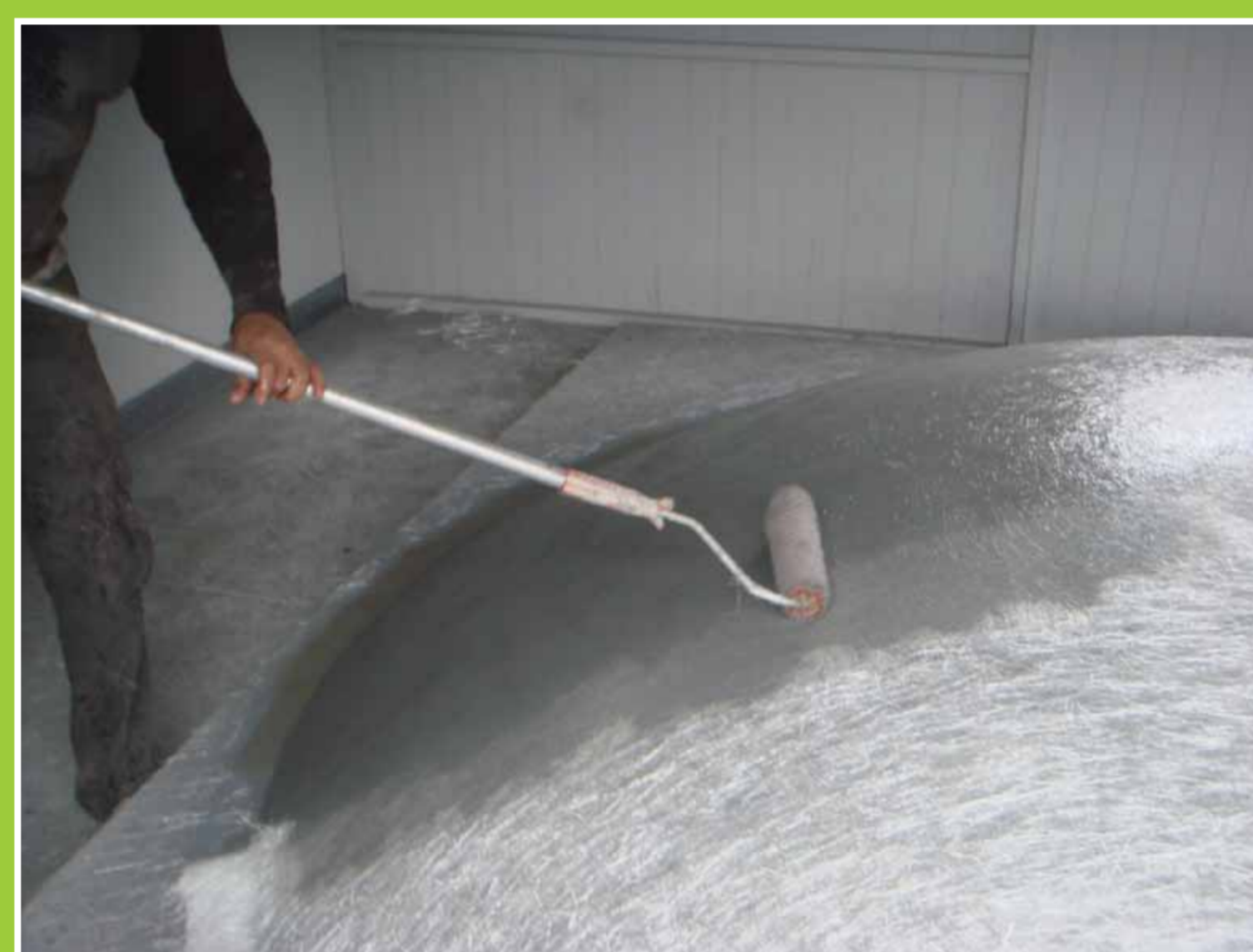
Aplicando resina sobre fibra de vidrio
