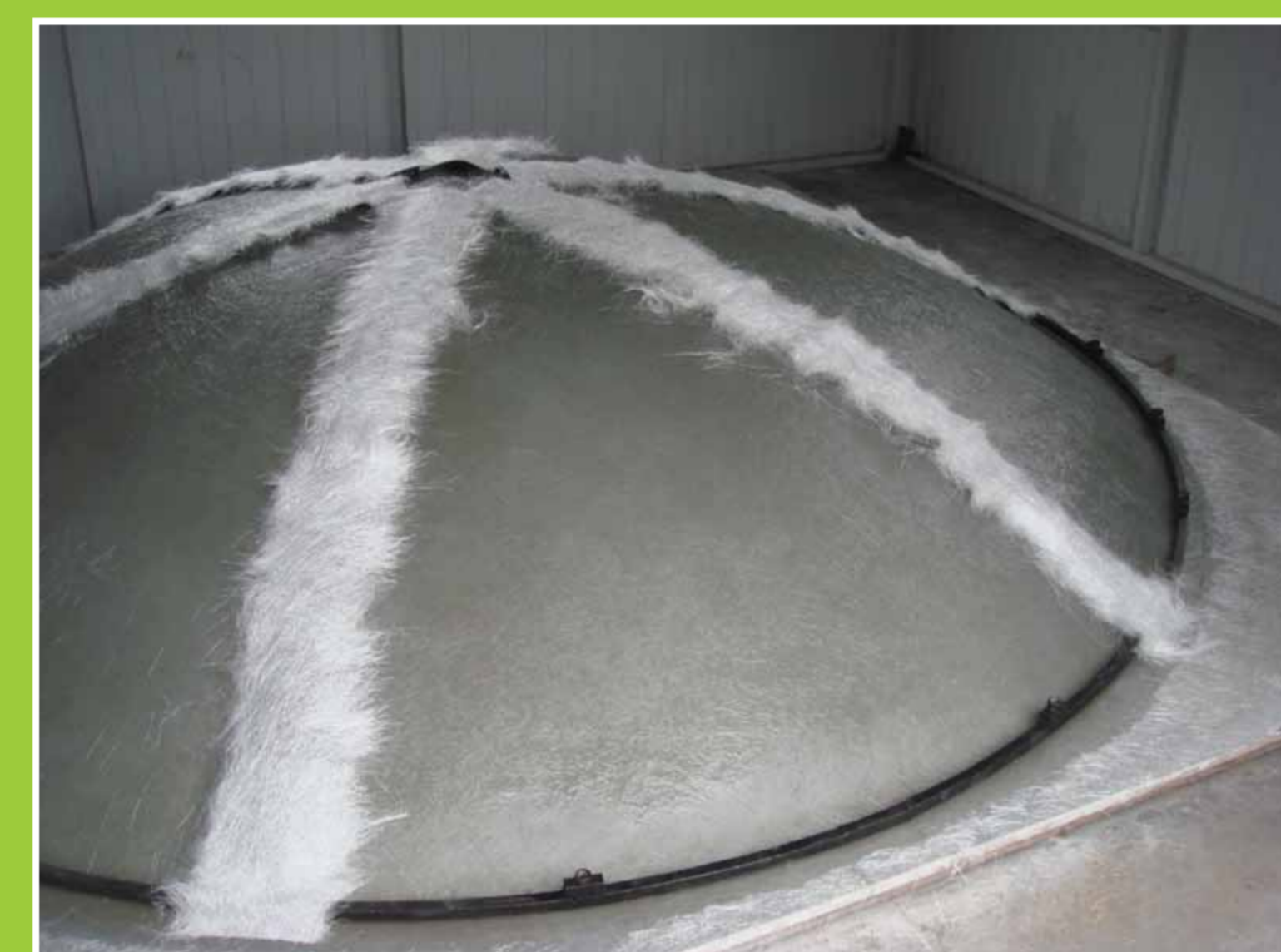
Colocando costillas y refuerzos
