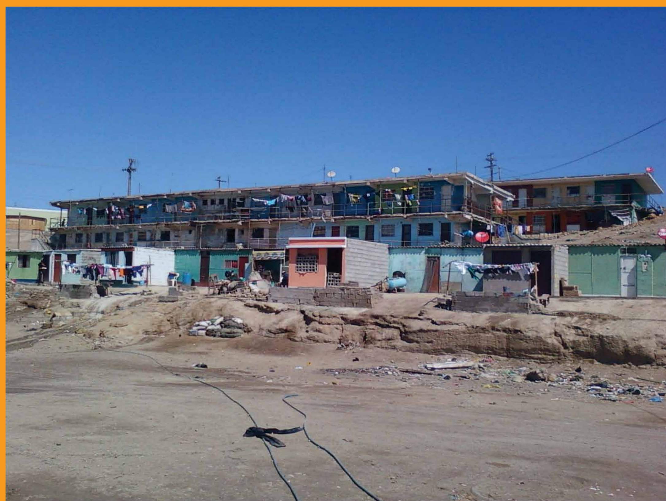
Cuartos de los trabajadores de Shougang, en Marcona-Ica. La empresa hace que muchos de sus obreros vivan en habitaciones de 20 metros cuadrados con toda su familia.
