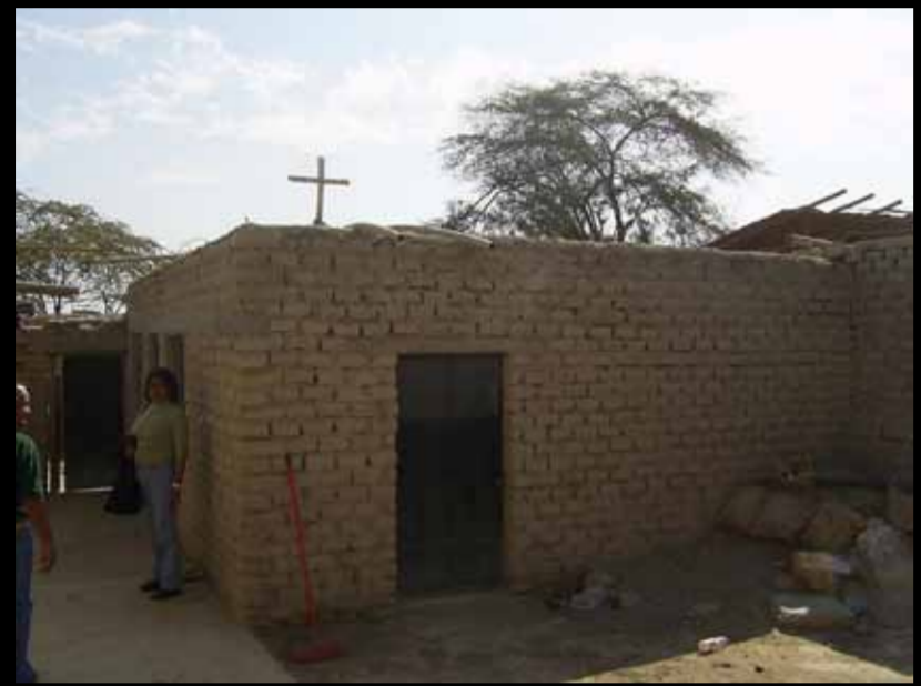
FIGURA 1 Casa de adobe de la costa del Perú.
