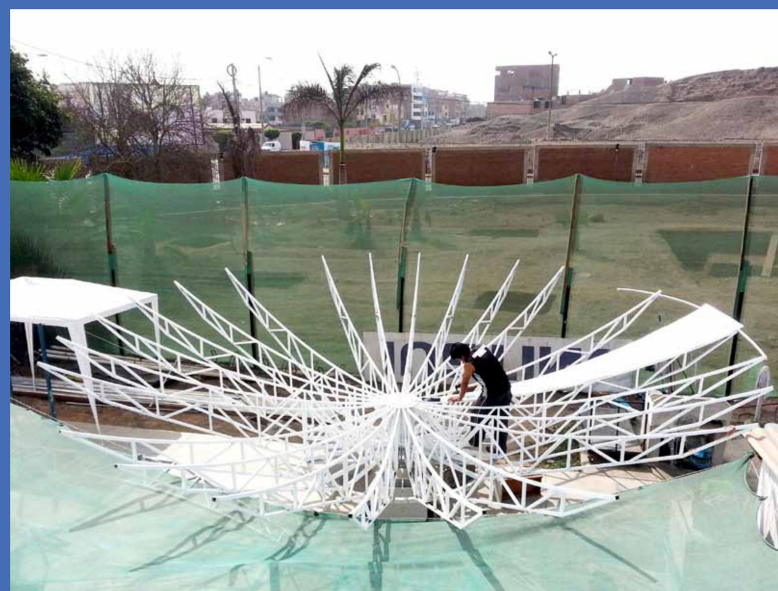
El radiotelescopio de 8 m de diámetro va tomando forma, mientras se prueba su nueva superficie de aluminio.
