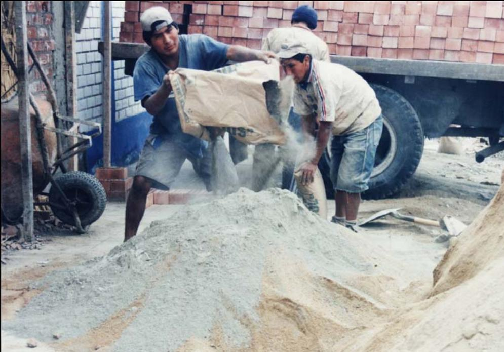
Se mezcla con la pala hasta obtener un color uniforme.
