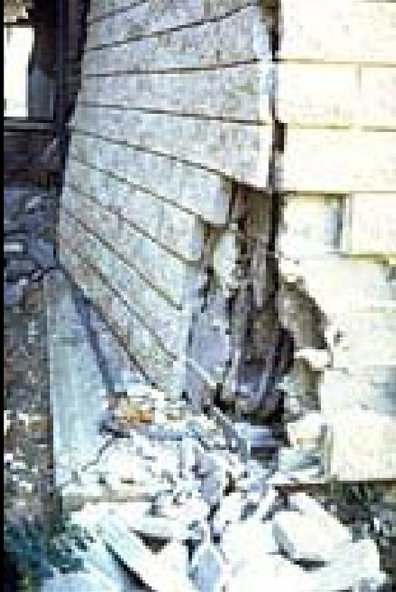
**Expansión del grout por efecto de Poisson y destape del bloque**
