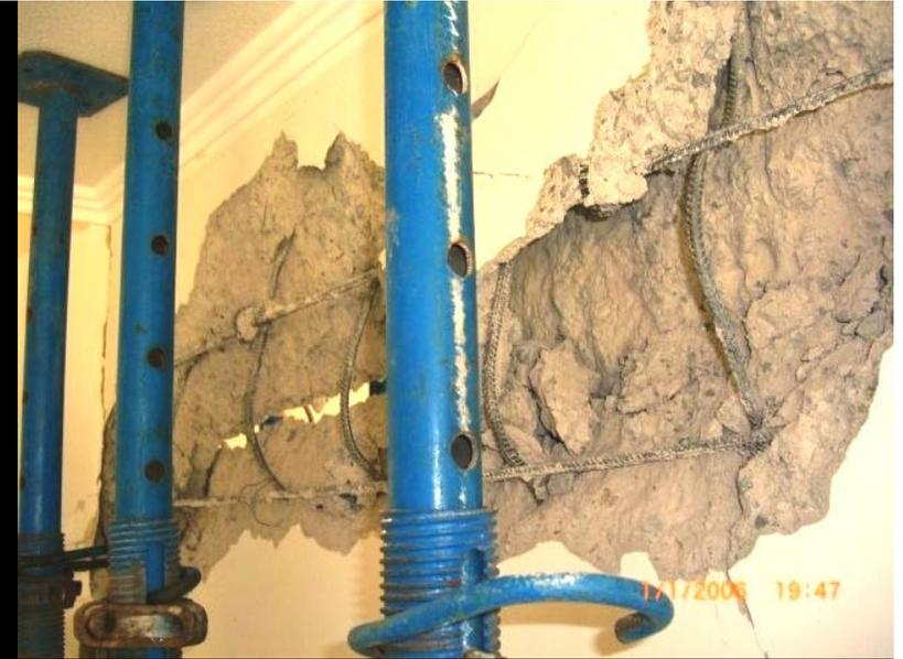
**Disminución sustancial del área de corte en una falla tipo reloj de arena y pandeo del refuerzo vertical interno. Chile-2010.**
