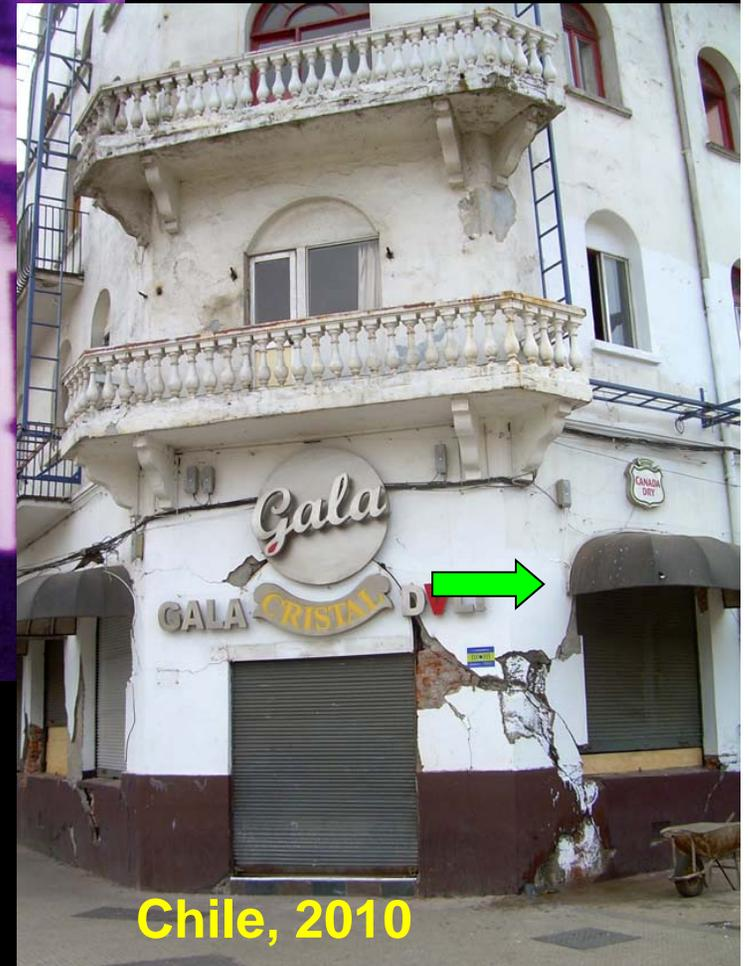
**ALBAÑILERÍA CON “As = 0”, FALLA POR CORTE**
