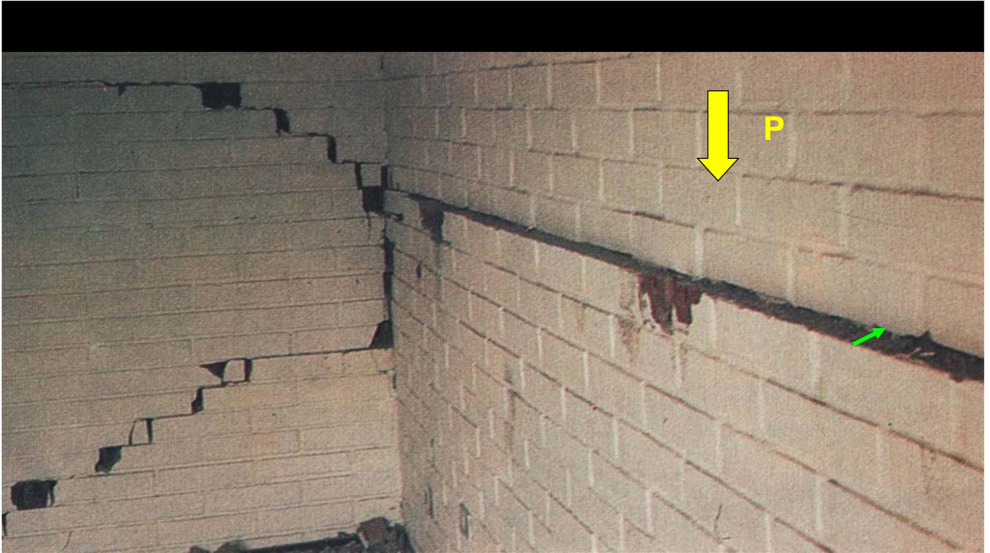
**FALLA POR DESLIZAMIENTO EN ALBAÑILERÍA ARMADA,
