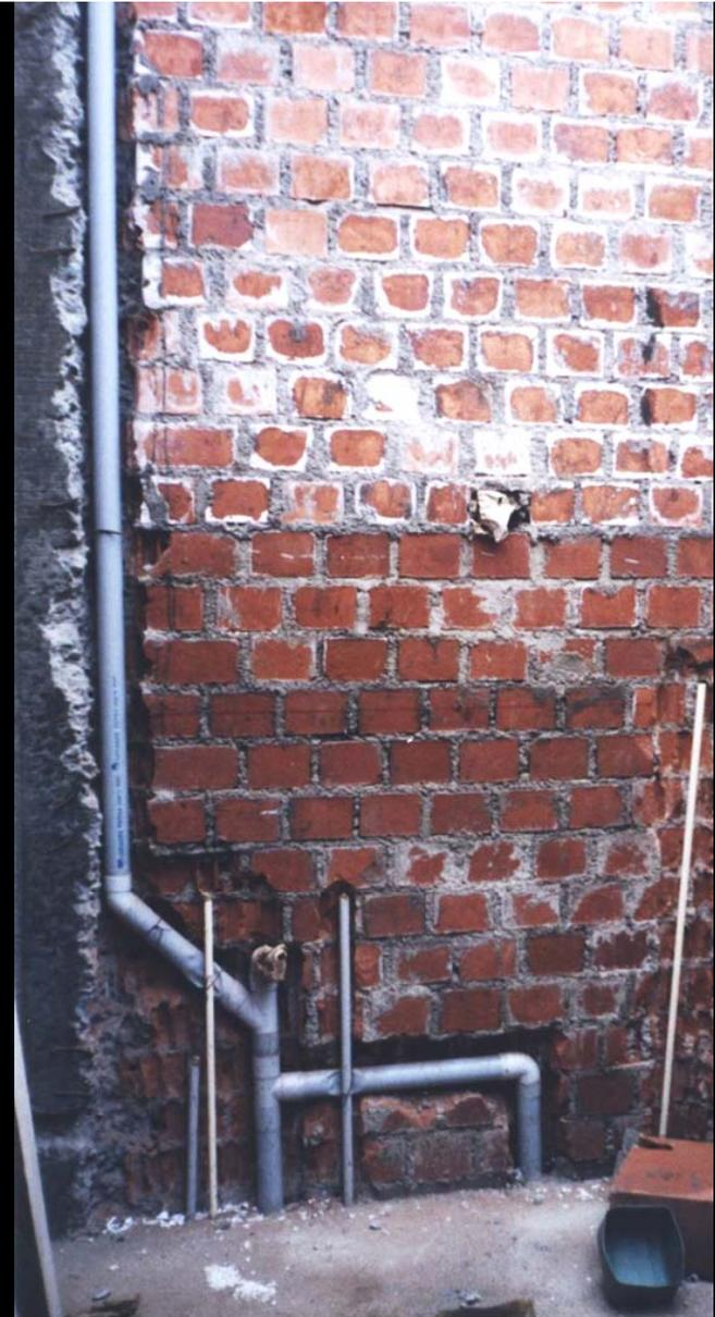
**1) Desintegración de la conexión columna-albañilería.**
