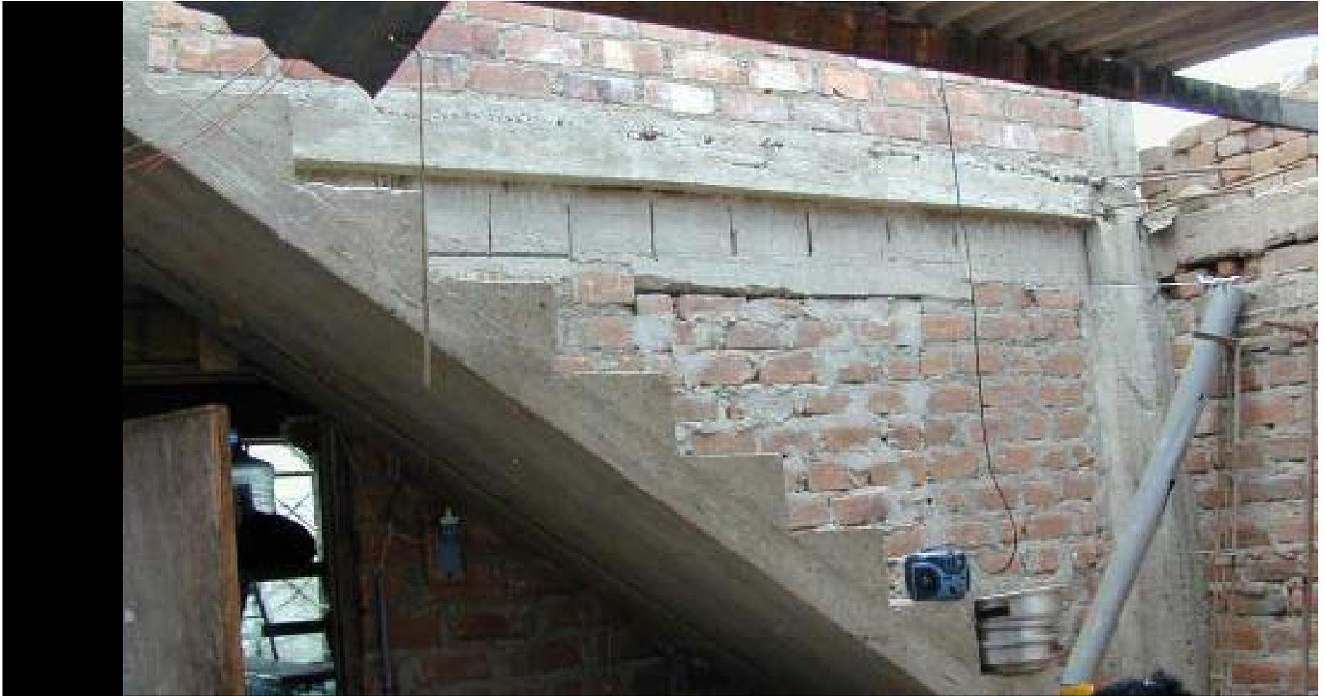
**Falta de recubrimiento en vigas**
