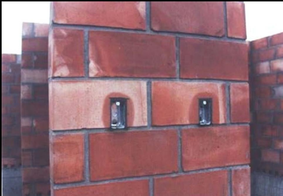
**Los tubos se instalan antes de construir el muro, dejando aberturas en los bloques para alojar las cajas eléctricas.**
