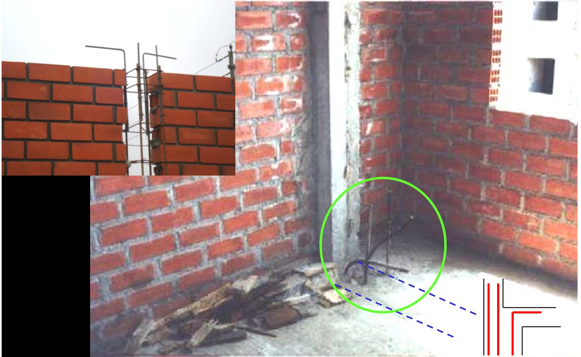
**Cambio de sección transversal en una columna. El refuerzo debió embutirse en la viga 12Db.**
