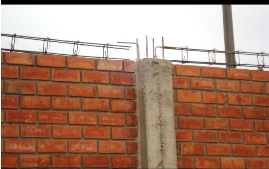
**Refuerzo longitudinal de la solera cortado**
