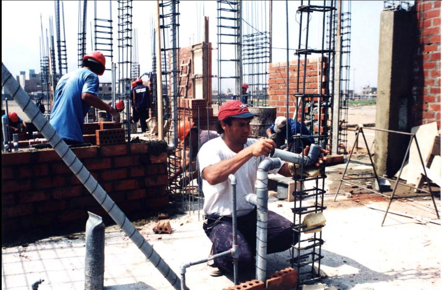
En nuestro medio se acostumbra picar los muros para después instalar los conductos ...
