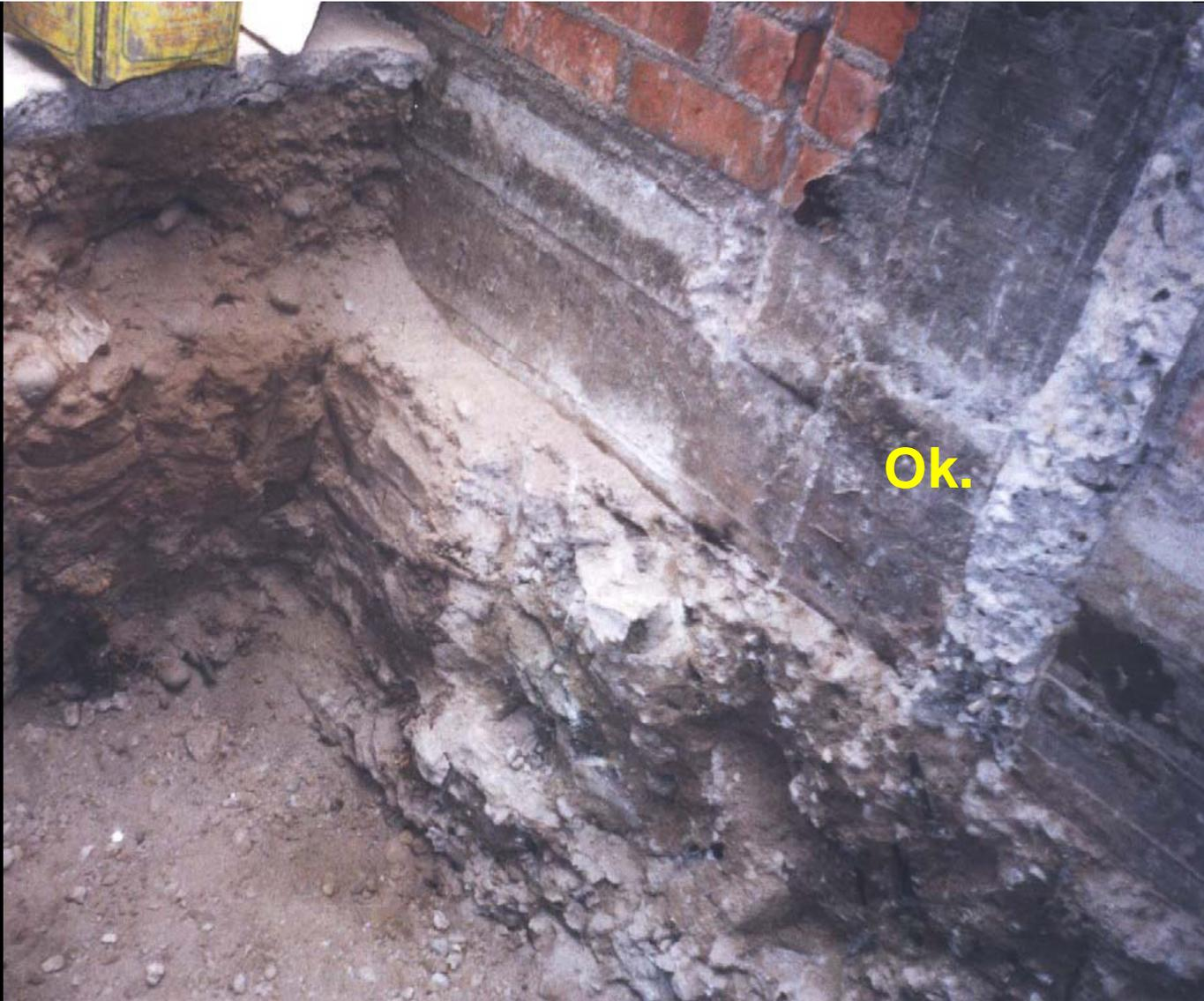
**Concreto del sobrecimiento de la misma calidad que el de la columna, aún así, agregar estribos en la col.**
