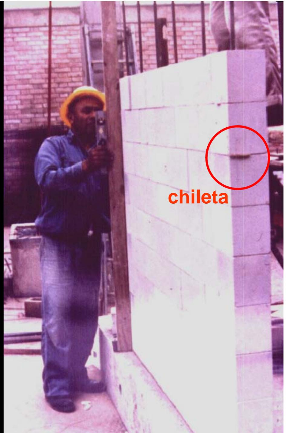
**Durante el apilado se instala el refuerzo horizontal**
