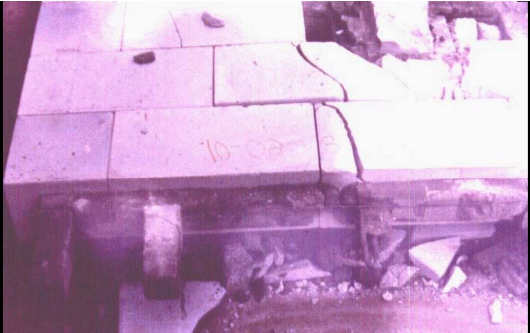
**Las columnillas de grout reforzadas, son las que proporcionan resistencia, rigidez y ductilidad al sistema.**
