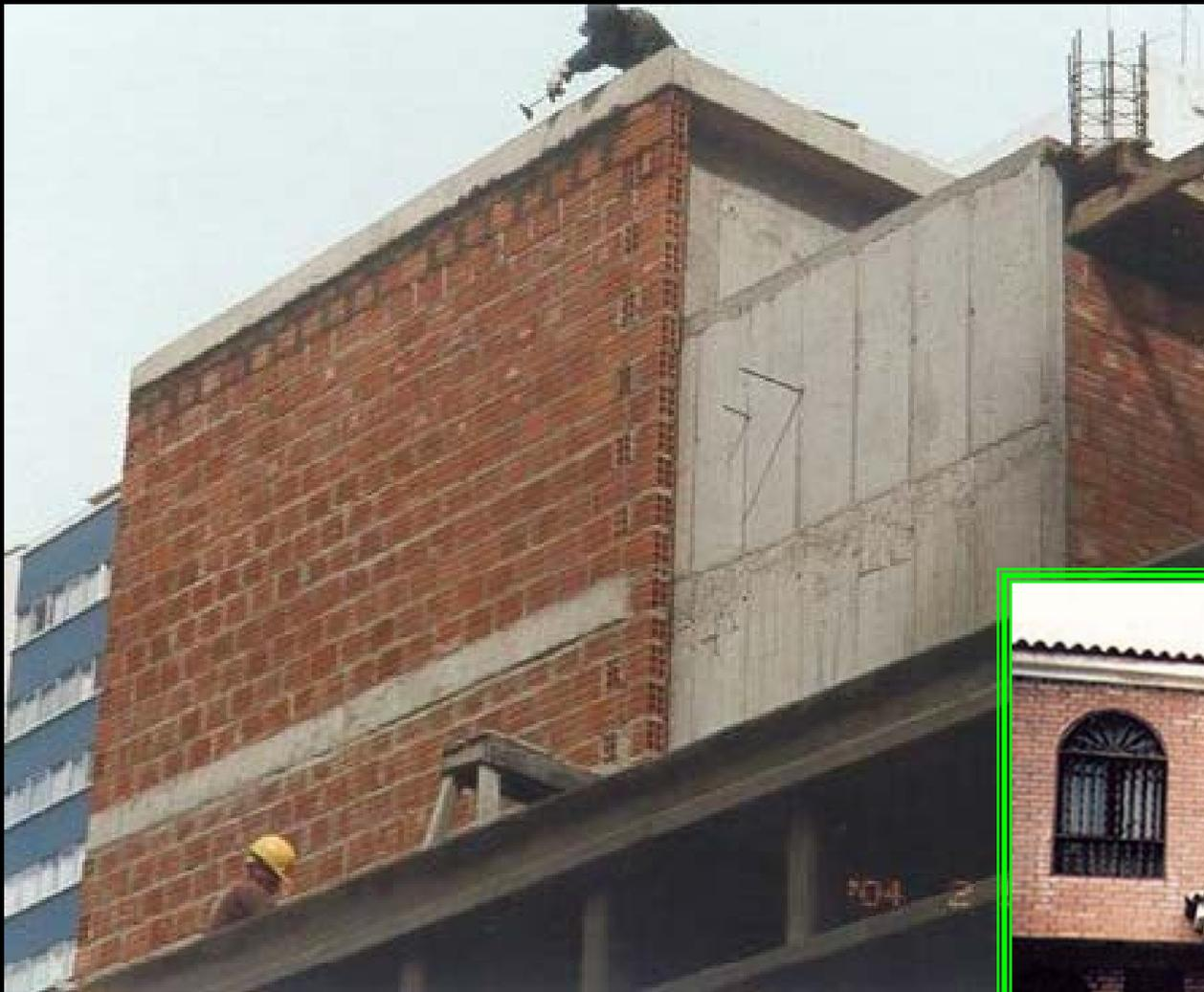
**Placa de concreto recubierta con un muro de albañilería. La Paz.**
