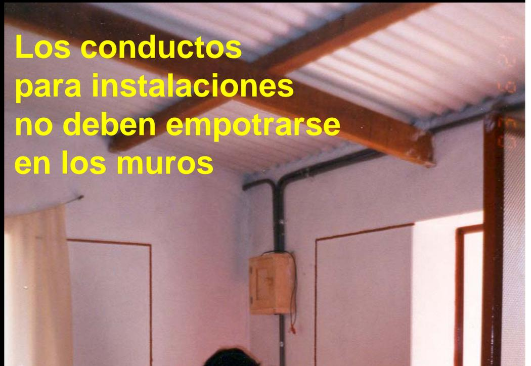
**Los conductos para instalaciones no deben empotrarse en los muros**
