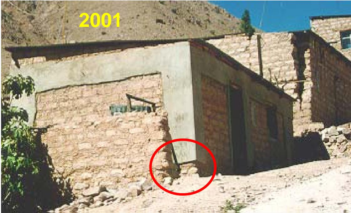
**La malla no necesita conectarse a la cimentación ya que la deformada del muro es por corte:**
