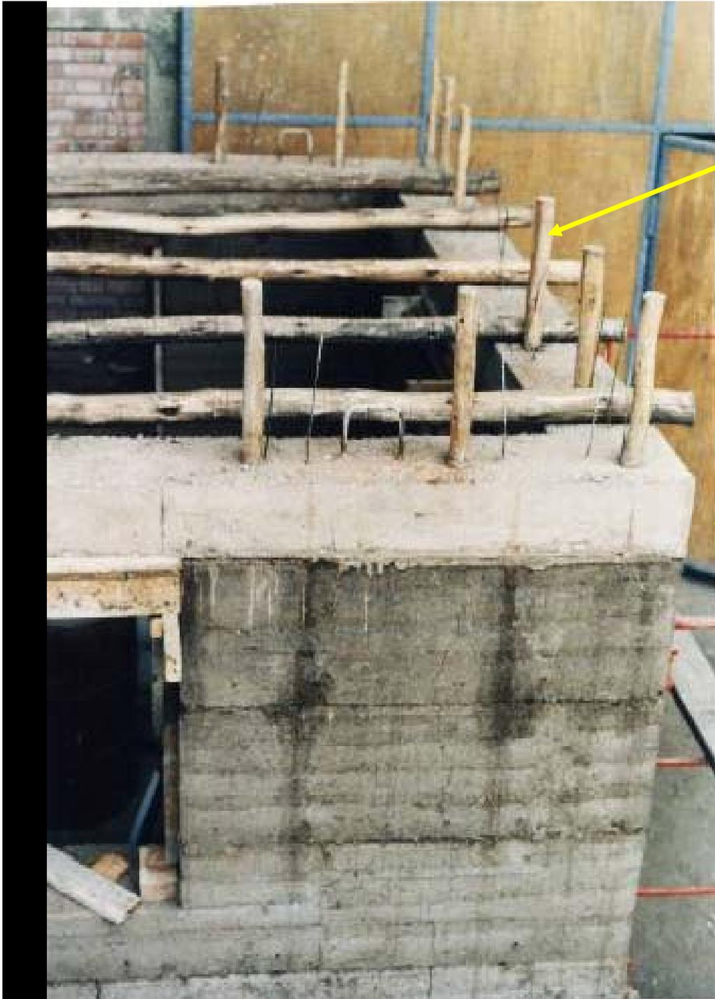
**troncos dentados sobre la solera y amarrados con alambre #8 embutido en la solera**
