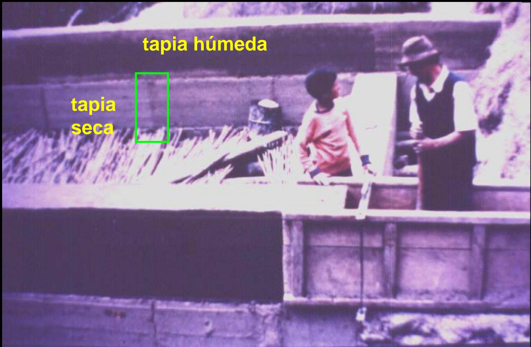
**La hilada superior debe construirse después que haya secado la hilada inferior (unos 3 días), de lo contrario, la grieta se extenderá hacia la tapia húmeda.**
