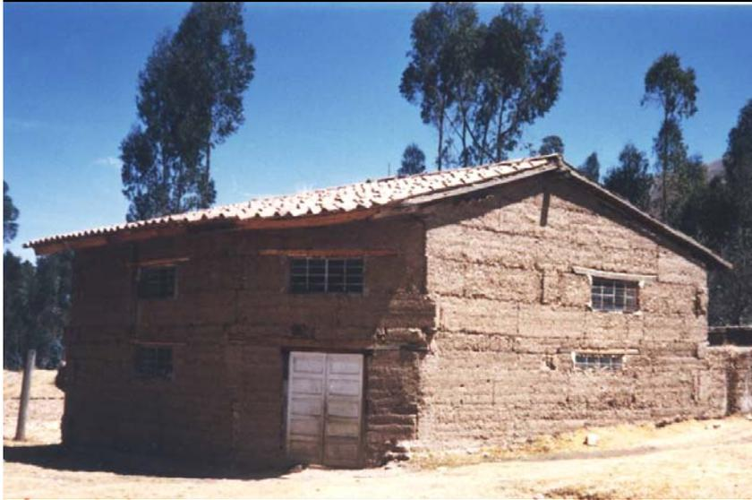
**El tapial es un sistema de construcción en base a tierra húmeda compactada in-situ, de gran uso en la Sierra.**
