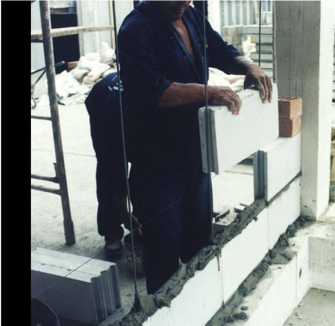
**Solo hay mortero en juntas horizontales y los bloques no se traslapan entre hiladas consecutivas**
