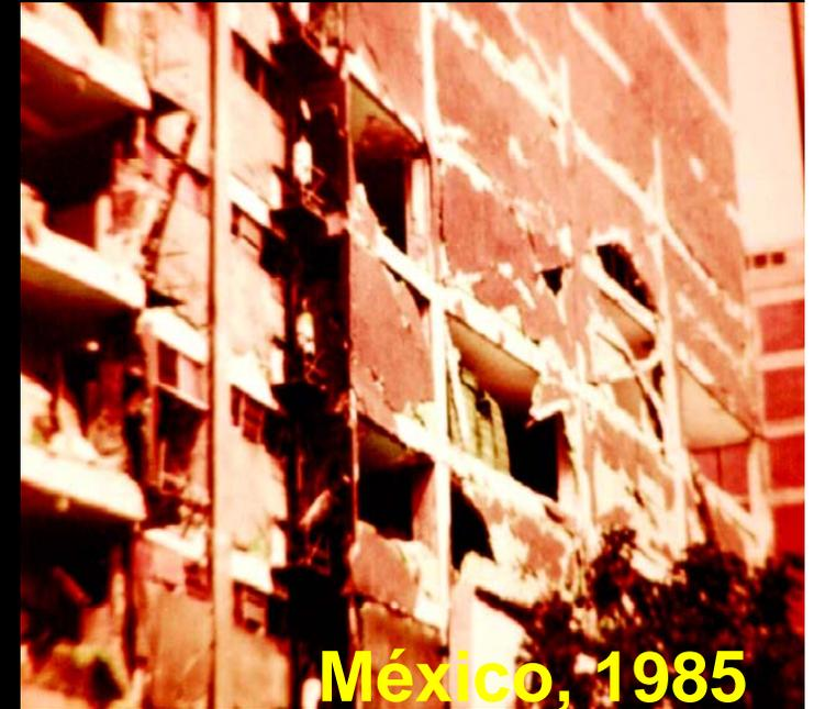
**Ante sismos severos, los tabiques Drywall no aportan resistencia ni rigidez → analizar a la estructura como si no existiesen tabiques.**
