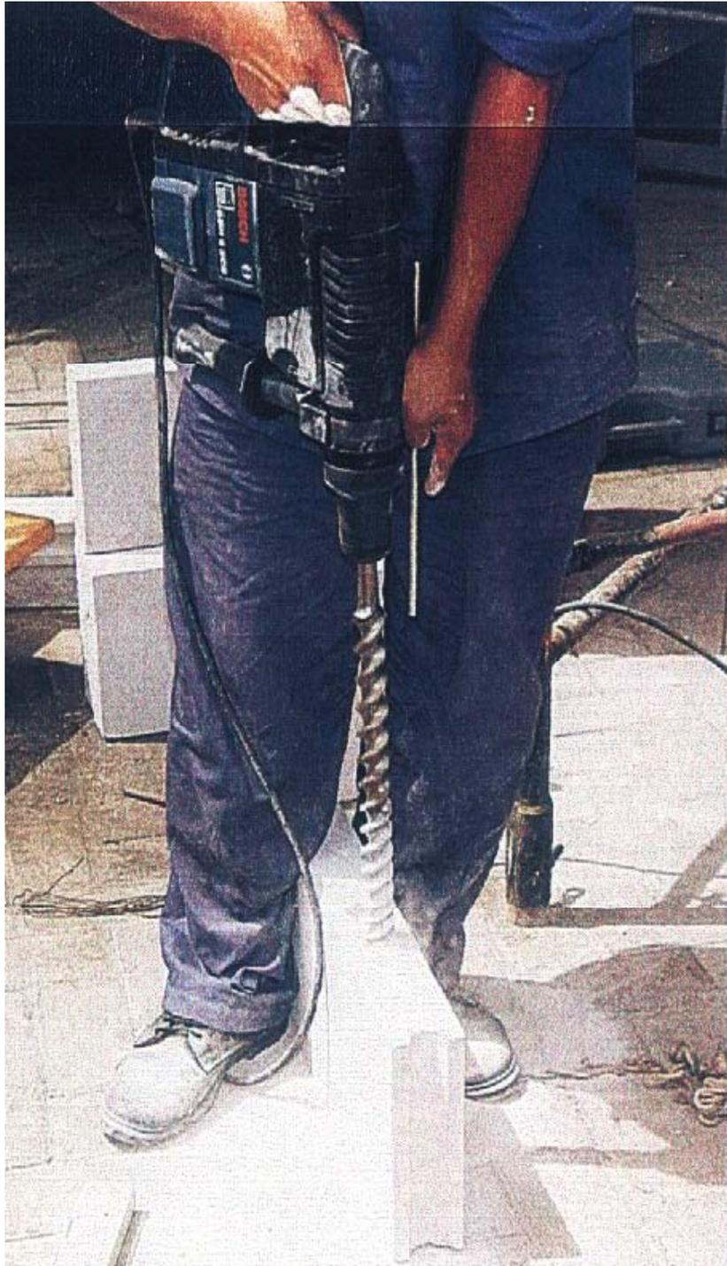
**Otra especificación del fabricante es taladrar a la placa P-7, para instalar los conductos eléctricos; sin embargo ...**
