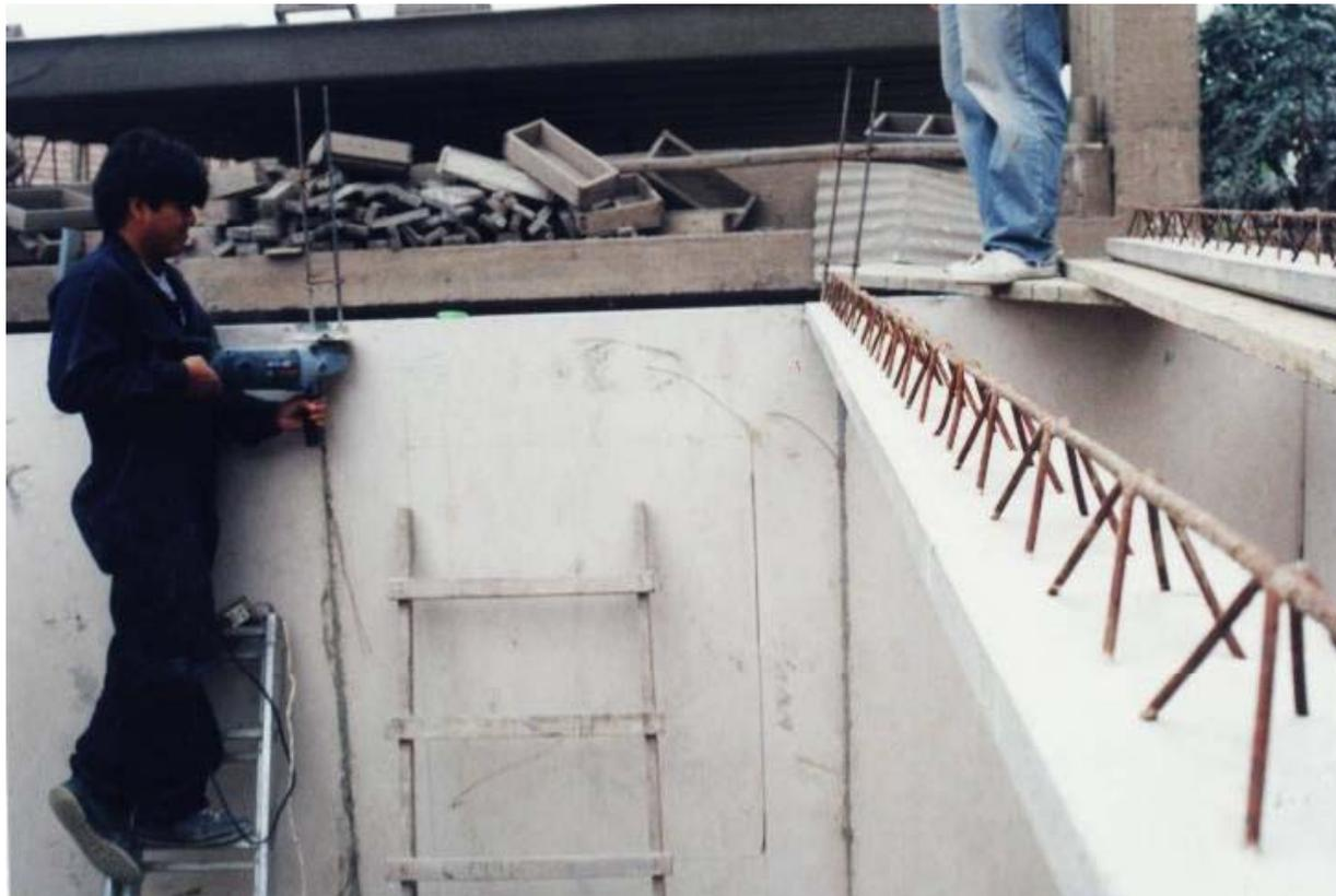
**Montaje de viguetas prefabricadas "Eurobau" en rebajos hechos en las columnas.**
