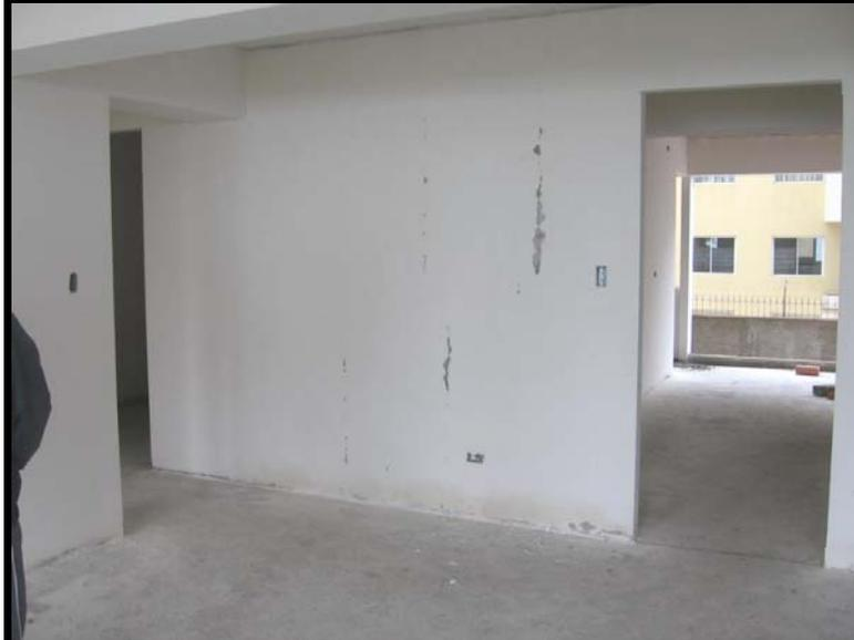
**Sismo de Pisco del 2007, sentido en Lima con  $a = 0.07g$  en suelo duro. → Se modificó el proceso constructivo dejando una junta vertical de 1cm, rellena con el grout.**
