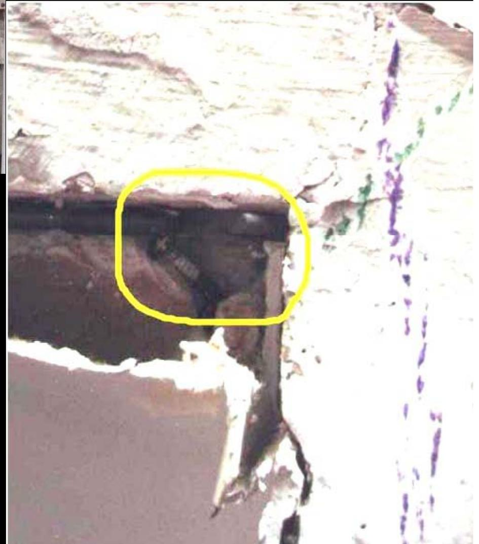
**Ante sismos moderados, se fractura la esquina, perdiéndose la interacción pórtico-tabique. El armazón metálico no proporciona resistencia ni rigidez.**
