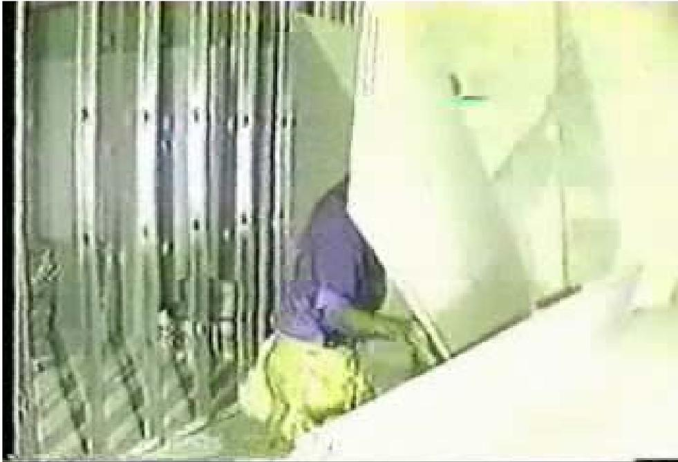
Luego las planchas se atornillan contra los perfiles. La base de la plancha debe quedar a 1 cm del piso.
