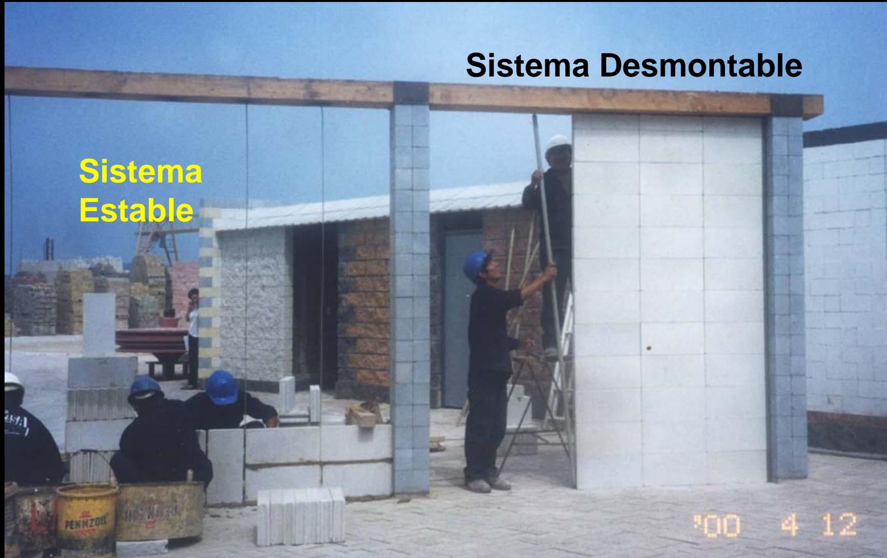
El ajuste entre pilares verticales se hace con un tubo PVC con pines en los extremos
