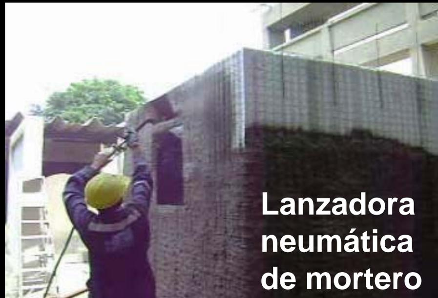
Lanzadora neumática de mortero
