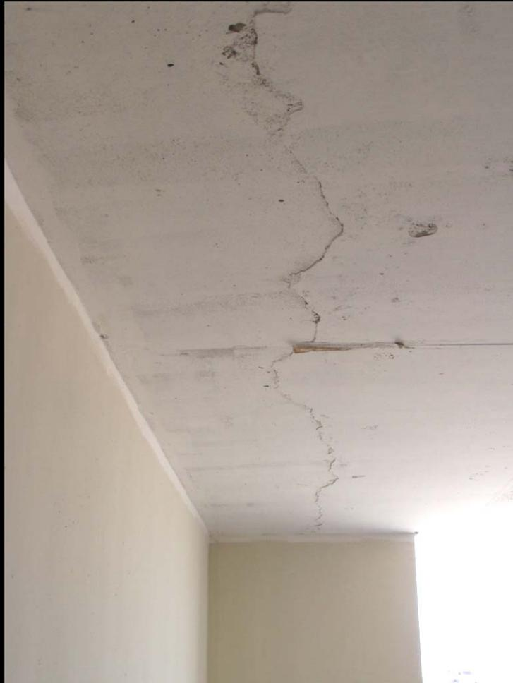
Al secar el concreto trata de contraerse, pero, al encontrarse restringido en sus bordes, se generan tracciones que originan fisuras, principalmente en zonas débiles, por ejemplo, donde existen tuberías. Estas fisuras pueden dar lugar a:
