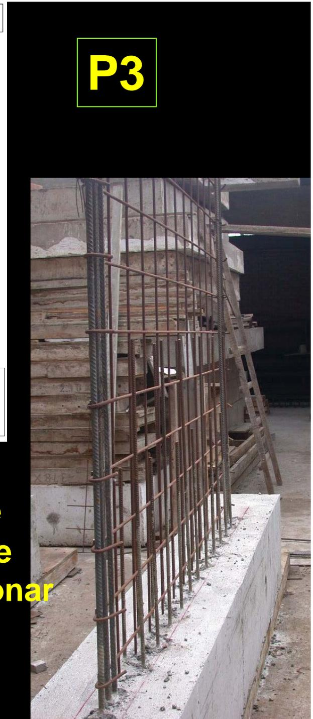
**Placa P3, junta rayada y con el doble de espigas. Las espigas adicionales a las de traslape tuvieron la función de proporcionar resistencia a cizalle.**
