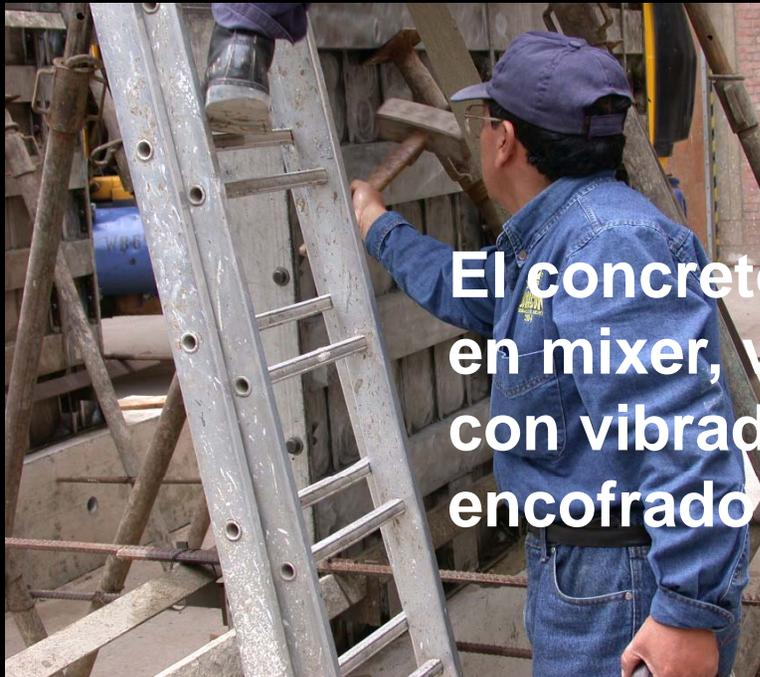
El concreto rheoplástico debe ser preparado en mixer, vaciado con bomba y compactado con vibradora de aguja o golpeando al encofrado externamente.
