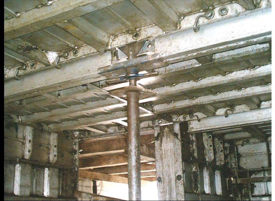
**Encofrado FORSA para Techo**
