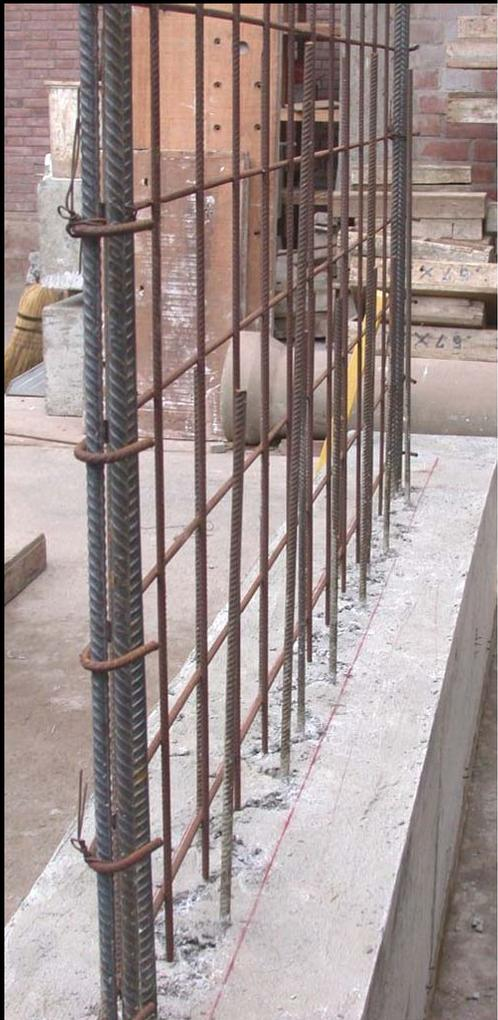
**Placa P2, junta rayada y espigas en zigzag de acero dúctil (sólo como traslape del refuerzo vertical de la malla)**
