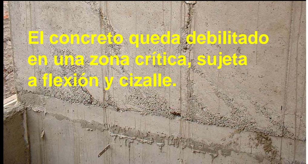
El concreto queda debilitado en una zona crítica, sujeta a flexión y cizalle.
