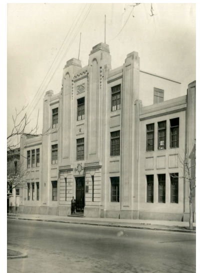
Local de la Escuela de Pedagogía en la Av. Bolivia
