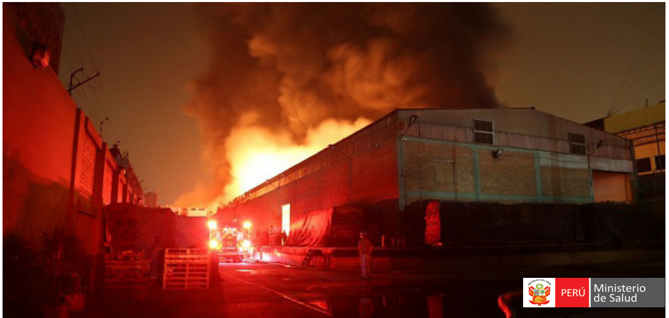
Almacén del Minsa durante el trágico incendio.
