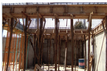
La construcción avanza...
