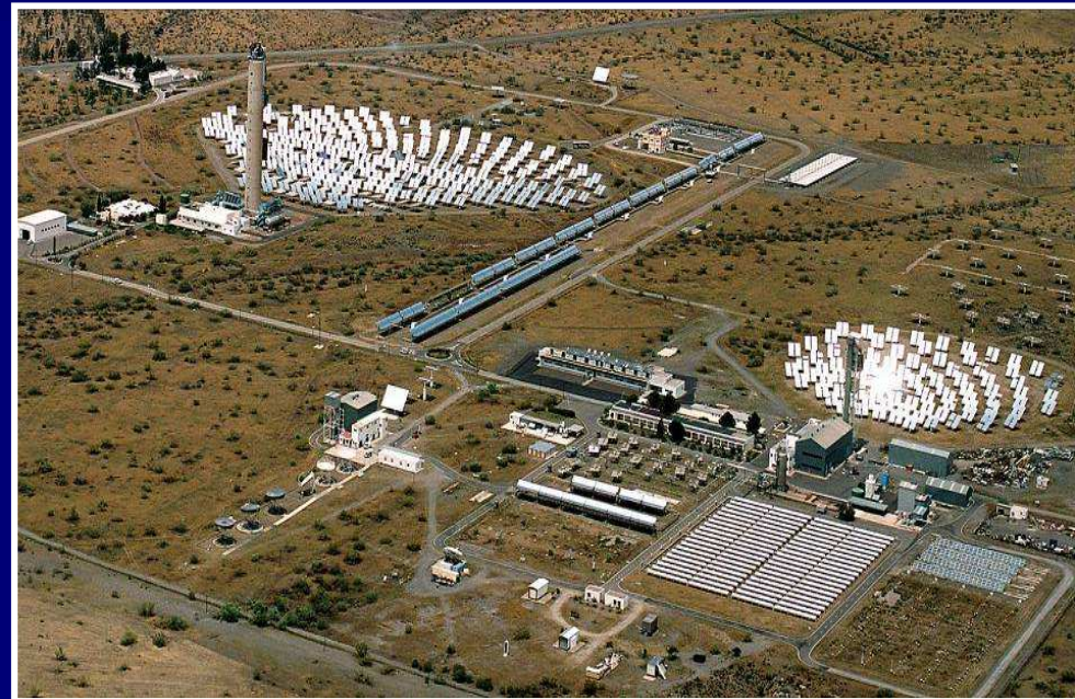
Plataforma Solar de Almería 1978-2011
