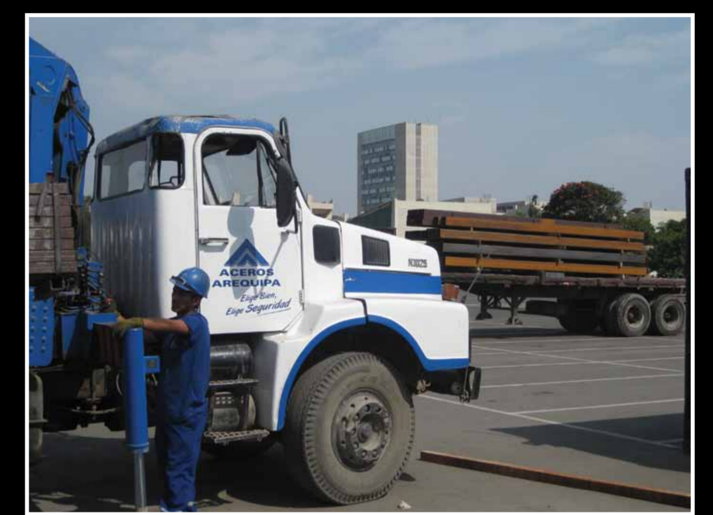
Descarga del acero estructural de Aceros Arequipa para el radiotelescopio RT-20
